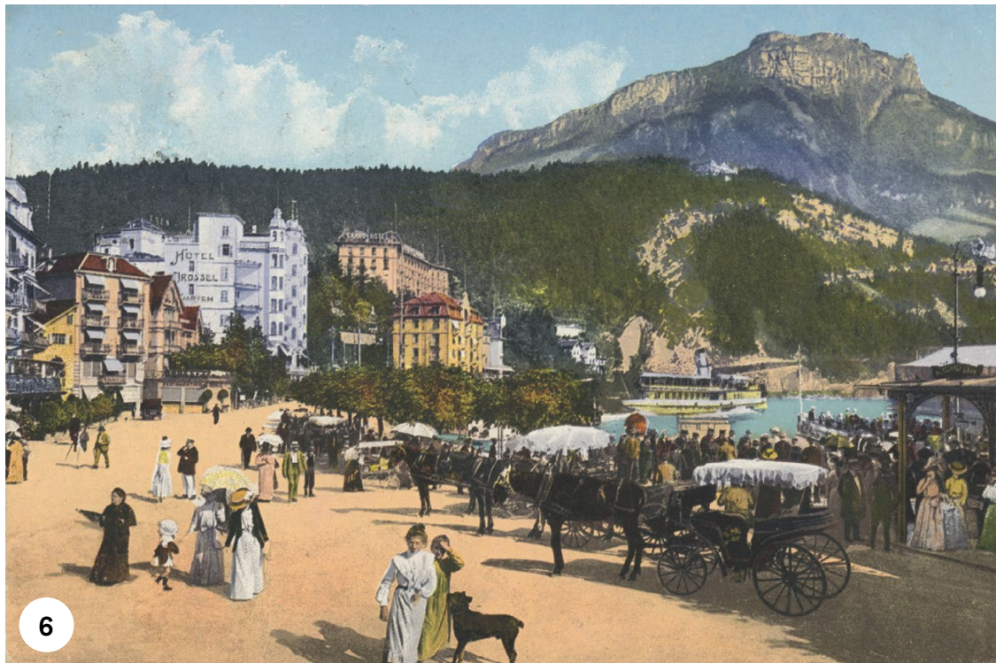
Brunnen sul lungolago, 1912.
